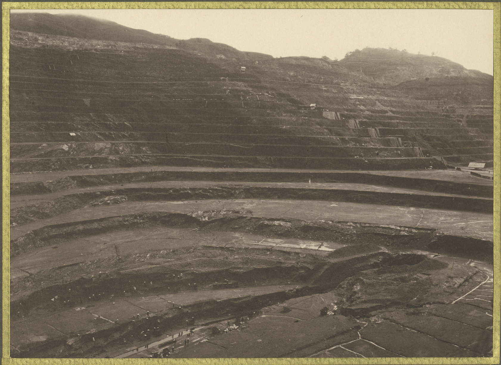
Hongay. Mines de Campha. Les gradins d'exploitation.
